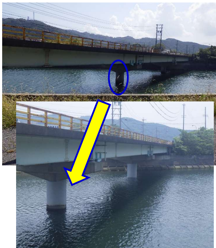
橋脚柱を補強しました
