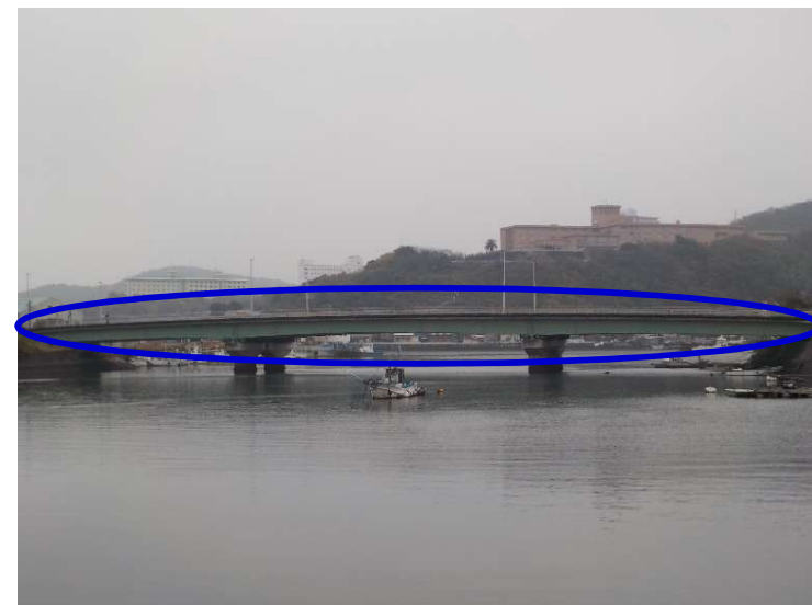
上部工を補強しています
