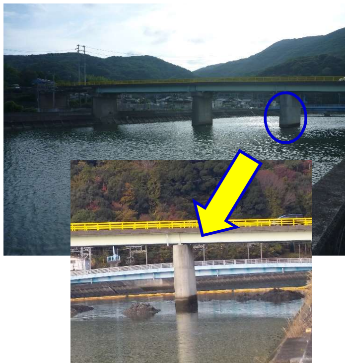
橋脚柱を補強しています
