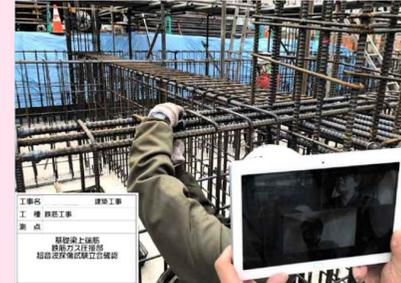
Webカメラを利用した遠隔検査
