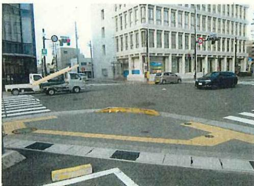
歩車道を分離するブロックがあるものの、カーブしており、車両が歩道に逸脱する恐れがある
