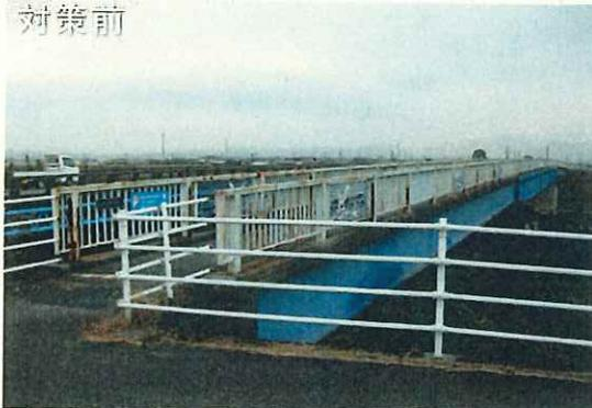
老朽化により高欄、主桁のサビが進行
