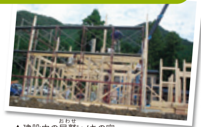
▲建設中の尾鷲ヒノキの家
