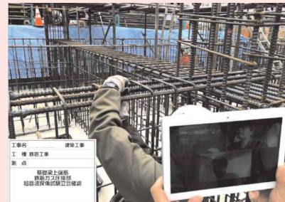
Webカメラを利用した遠隔検査
