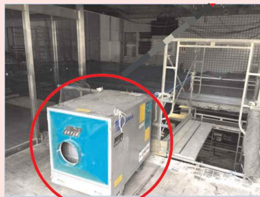
集塵機を設置し室内の換気を実施
