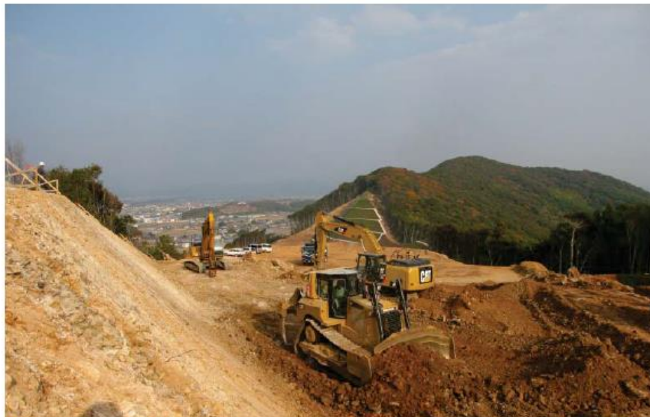
掘削(切土)施工中
