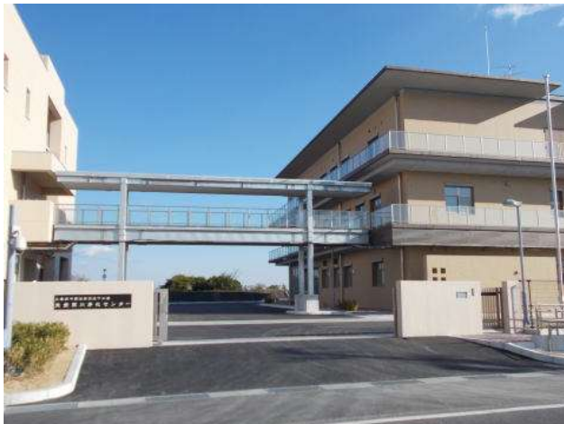
志登茂川浄化センター
