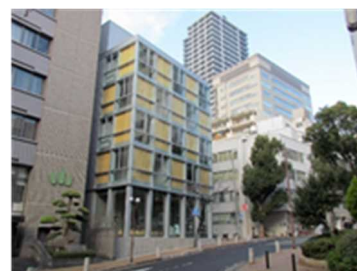
兵庫県林業会館（神戸市）
