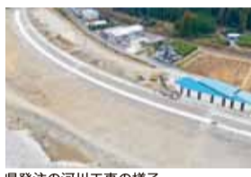
県発注の河川工事の様子
