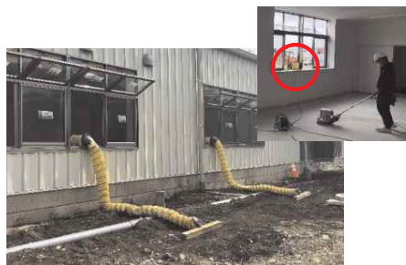
送風機を稼働し、埃を外部へ排出
