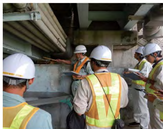
損傷の確認状況(主桁)
