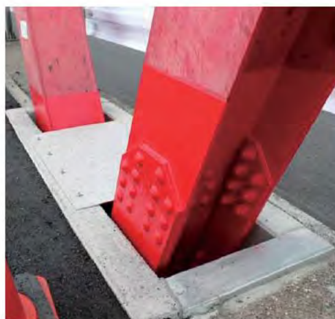
修繕後の状況(当て板補修・開口部設置)
