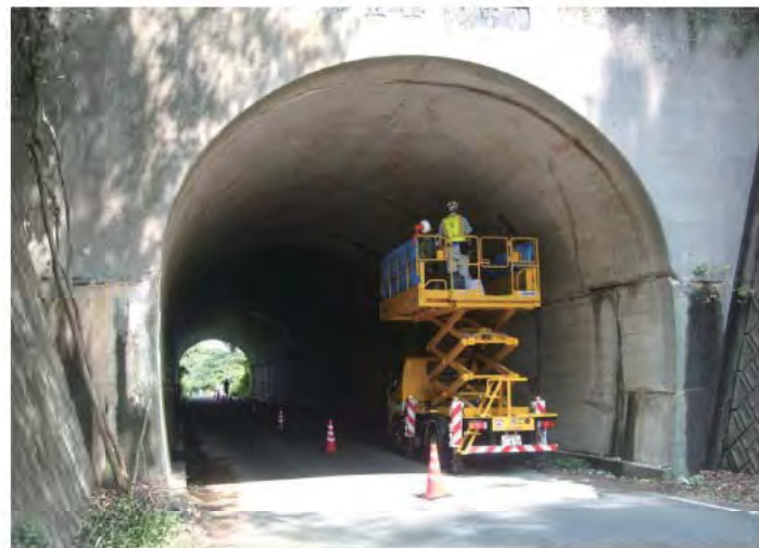
(トンネル点検の様子)
