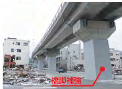
耐震補強済み(鋼板の巻立補強) 地震動による損傷なし(東日本大震災)
