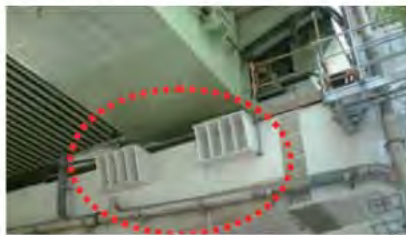
縁端拡幅ブラケットによる桁の落下防止
