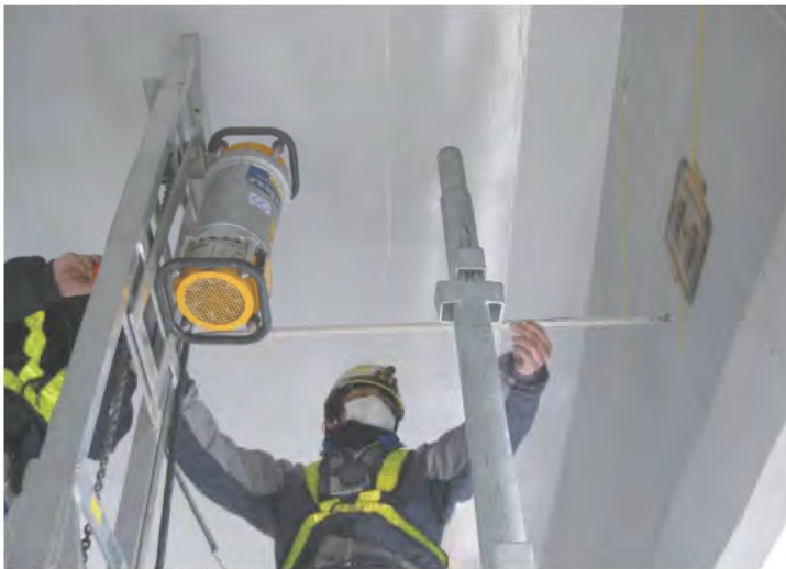
国道1号和瀬川橋（静岡国道事務所）
