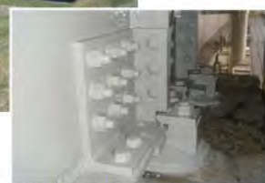
(当て板補強・塗装の塗り替え)
