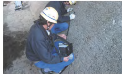
国道246号小山橋（静岡国道事務所）
