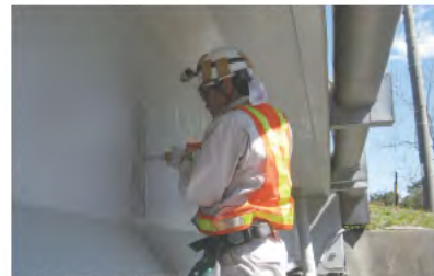
国道1号和瀬川橋（静岡国道事務所）
