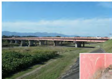
(塗装の劣化により腐食が進行)
