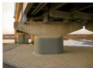
対策後(鋼板巻き立て工)
