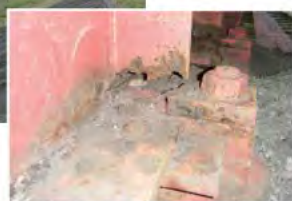
(塗装の劣化により腐食が進行)
