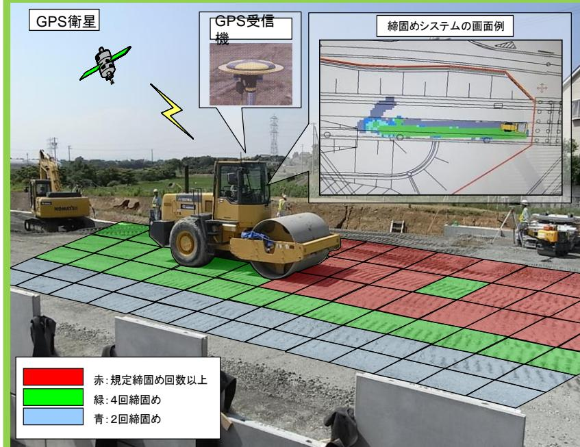
GPSを用いて、締固め機械の自己位置の計測を行い、施工箇所のメッシュを通過する回数をカウントするシステム(施工前に、回数と密度の相関を試験する)
