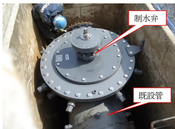
不断水工法による制水弁の設置状況
