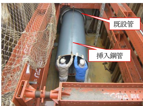
P I P 工法による既設管への鋼管挿入状況
