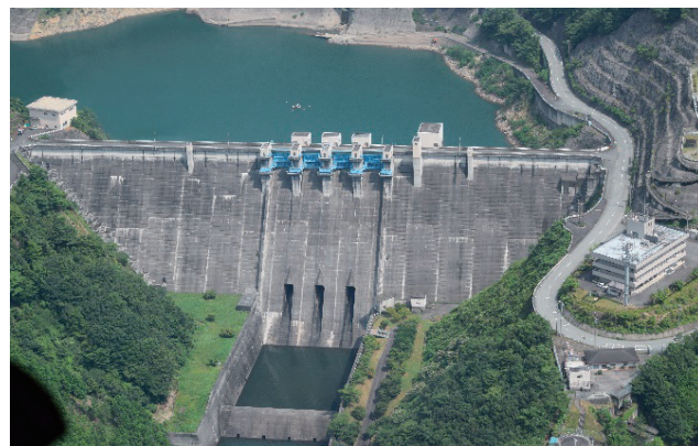
上空から撮影した蓮ダム
