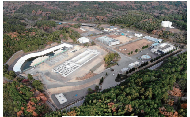
大里浄水場（全景）
