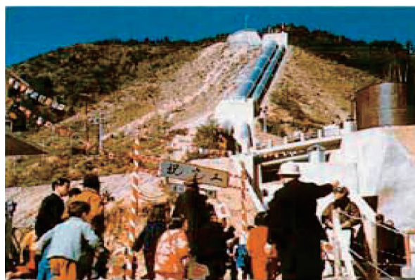
宮川第二発電所完工式
