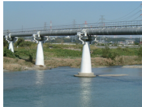
耐震補強後の水管橋
