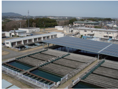
北中勢水道 高野浄水場
