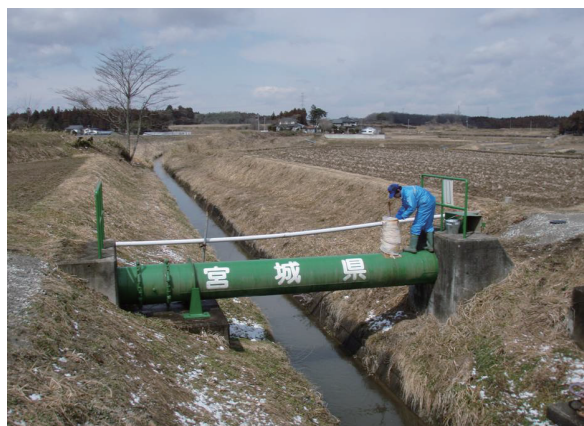
水道施設・管路の点検(宮城県)
