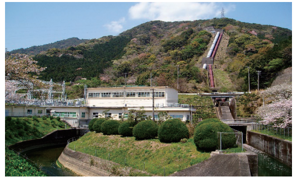
宮川第二発電所
