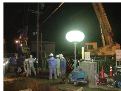
夜間の漏水復旧作業
