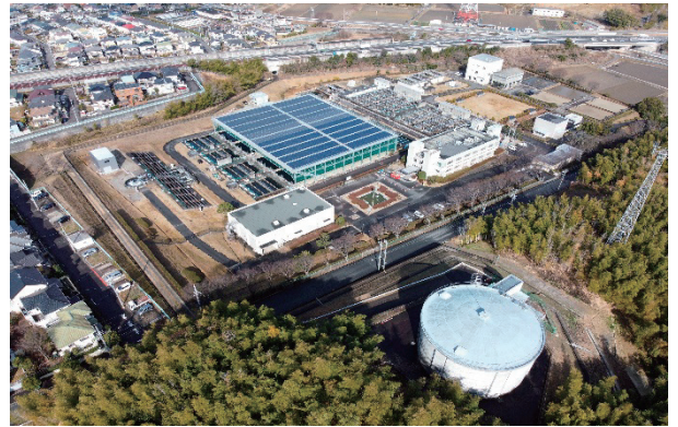
播磨浄水場（全景）
