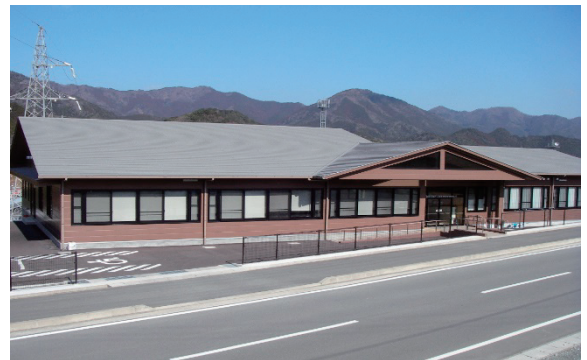
三瀬谷発電管理事務所
