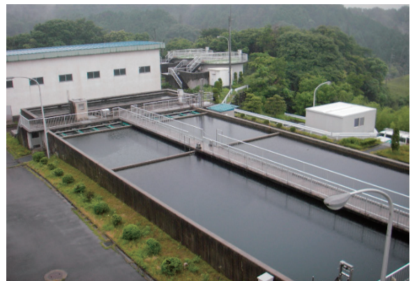
多度浄水場（撤去以前）
