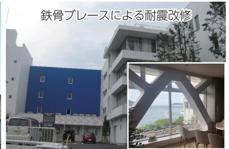
鉄骨ブレースによる耐震改修
