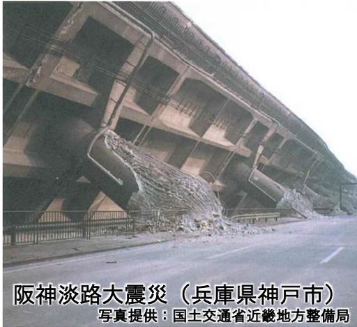
阪神淡路大震災以前の基準で設計された橋梁は、関東大震災クラスの地震をもとに設計されており、阪神淡路大震災クラスの大規模地震が発生した場合、橋脚等が損傷し、長期間通行が出来ないリスクがあります。このような橋梁等が、緊急輸送道路で553橋確認されています。
