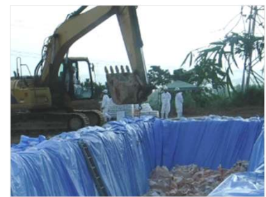
令和元年7月 CSF緊急対応状況 (いなべ市)
