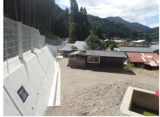
● 急傾斜地崩壊対策事業（森家野地区：松阪市）
