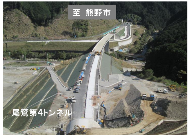
⑤熊野尾鷲道路（Ⅱ期）（尾鷲市南浦地内）
