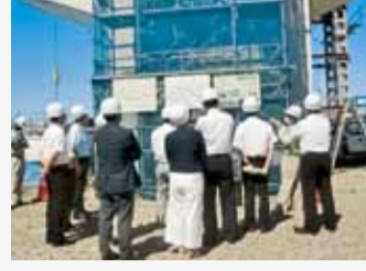
国道23号中勢バイパス鈴鹿工区の工事現場での調査の様子
