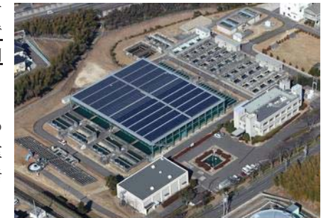
太陽光発電設備（播磨浄水場）
