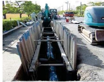
管路布設替えの状況
