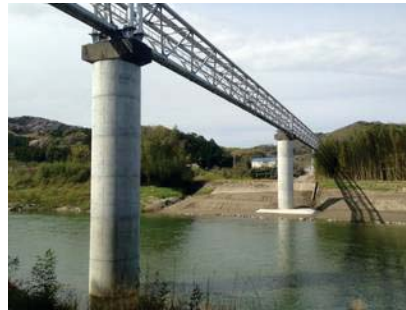
榊田川水管橋下部工の耐震化
