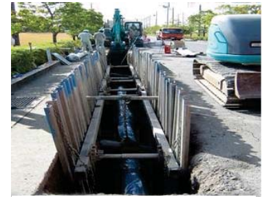
管路布設替えの状況
