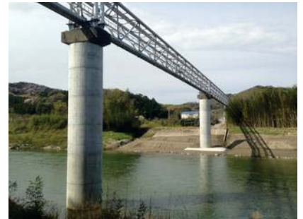
榊田川水管橋下部工の耐震化
