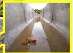
落下したアカガエル
