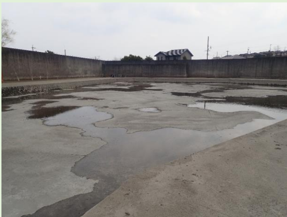
人工的な調整池 三面コンクリート
