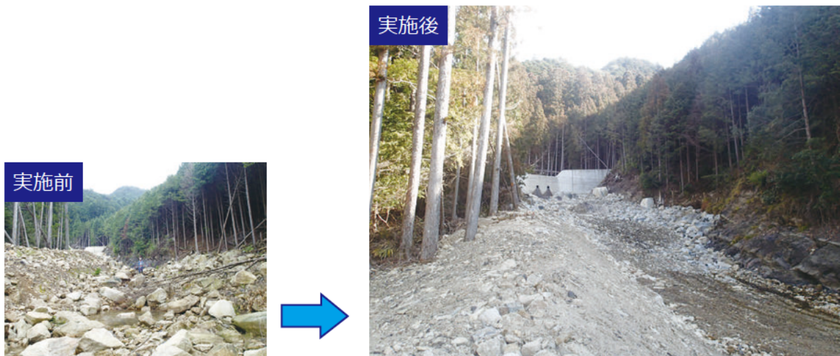
写真 土砂・流木緊急除去事業実施状況 熊野市 (桑瀬谷)
