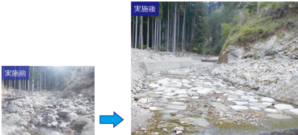
写真 土砂・流木緊急除去事業実施状況 熊野市 (清水谷)
