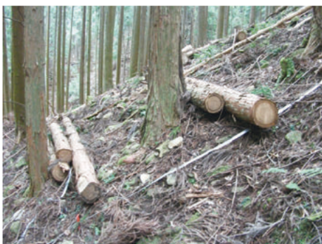
写真 伐倒木を利用した土砂止め
