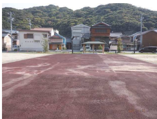
(写真 66) 阿曾浦公園ウッドチップ舗装整備事業 公園におけるウッドチップ舗装
