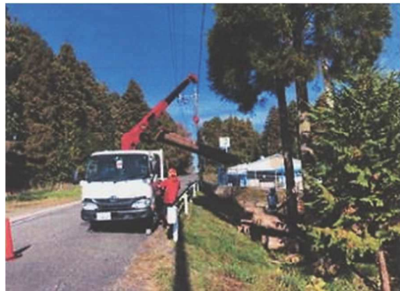
(写真 40) 危険木の除去事業 自治会による危険木の伐採の様子
