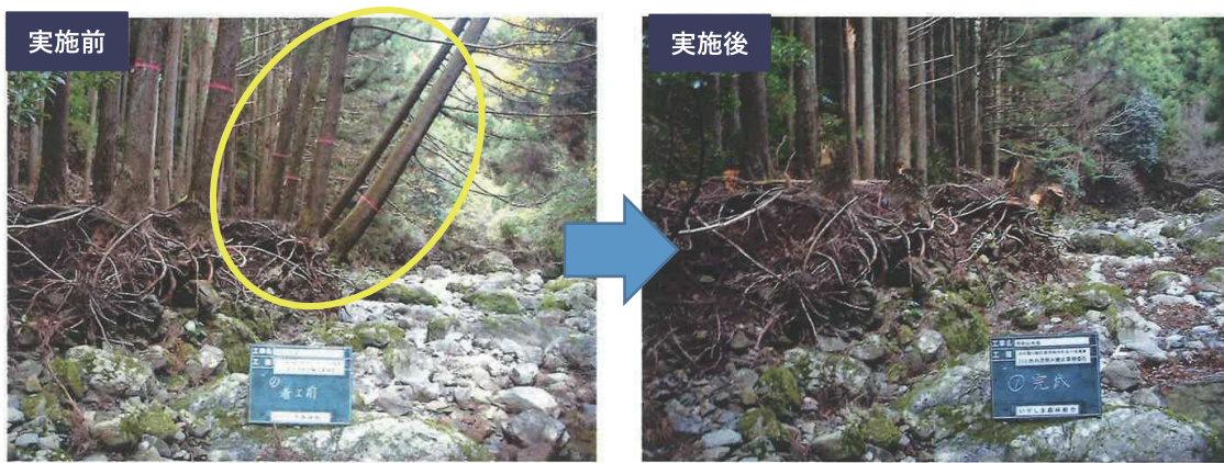
(写真 63) 流倒木撤去事業 河川沿いの倒木や倒れそうな立木の除去
