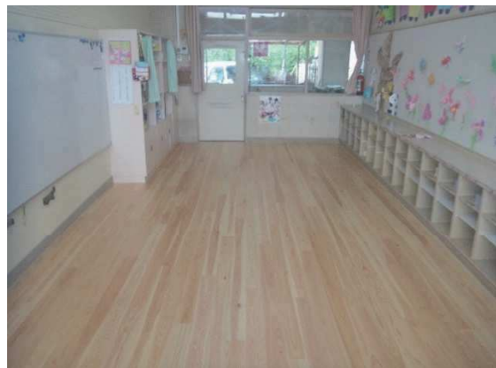
(写真 62) 公共施設（学び場）整備事業 県産材で木質化した保育所の保育室
