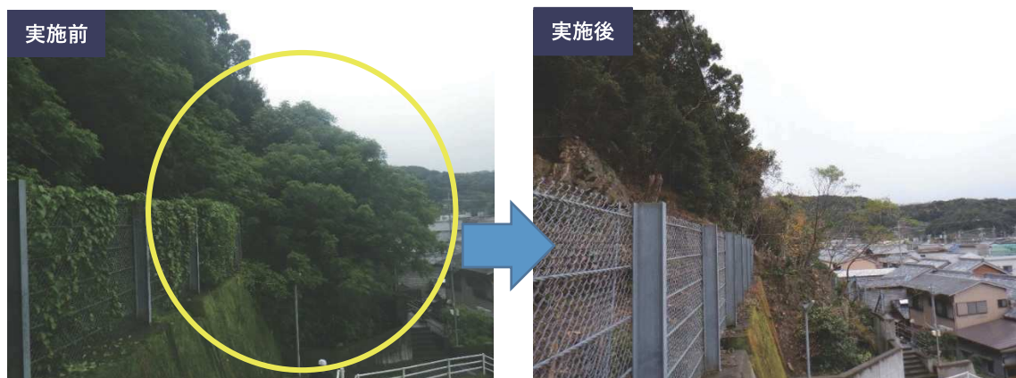
(写真 64) 生活環境林整備事業 人家裏の倒れそうな危険木の除去
