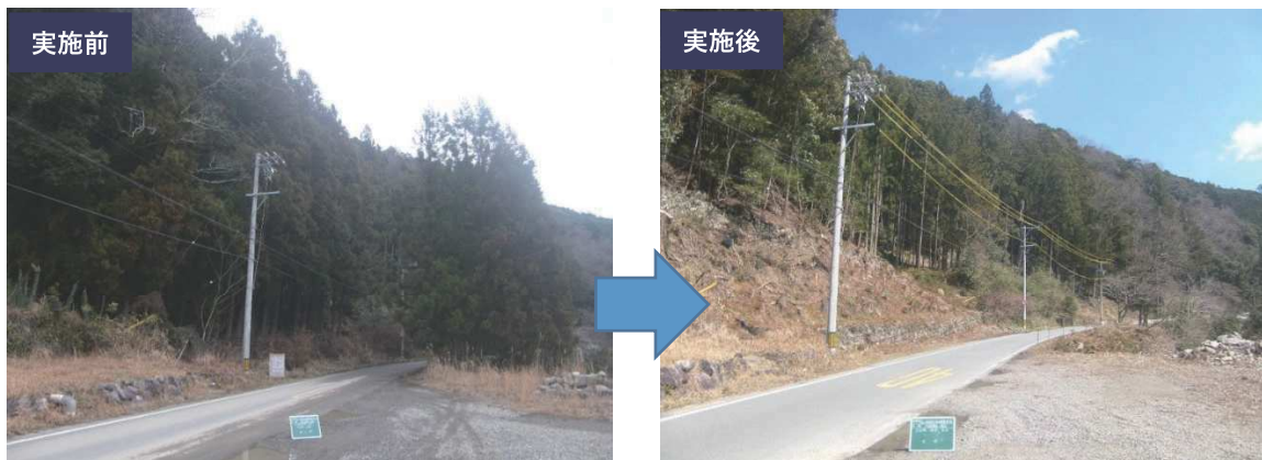
(写真 56) ほっとする道ばた森林整備事業 道路沿いの危険木の伐採
