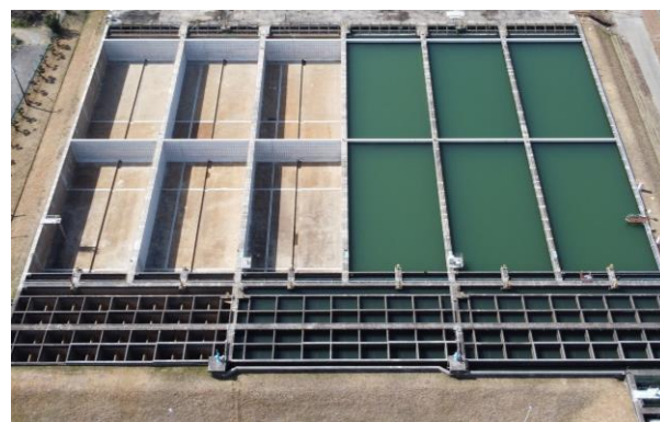
耐震補強工事が完了した伊坂浄水場 (令和3年度完了)
