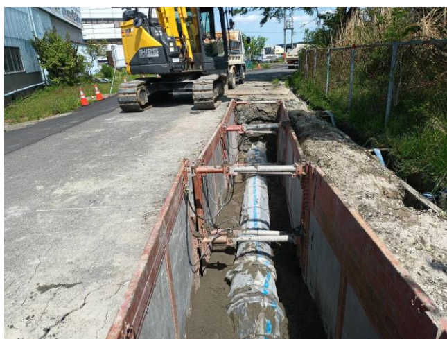
耐震管布設工事の施工状況 (内径450 耗送水管布設替)
