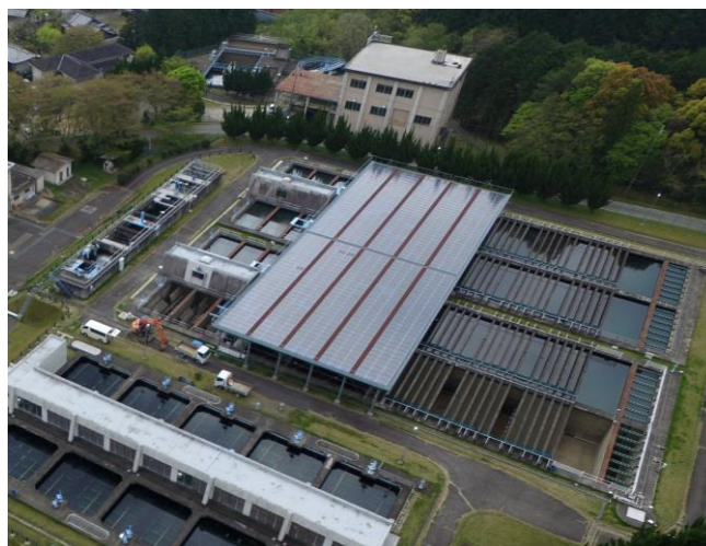
高野浄水場耐震補強工事の施工状況
