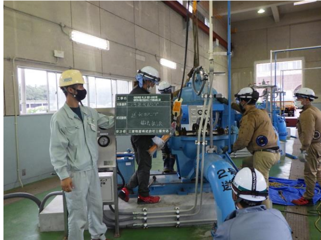
ポンプ設備の分解点検の状況 (送水ポンプ分解点検)
