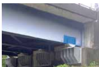
⑪国道 169 号(熊野市)
