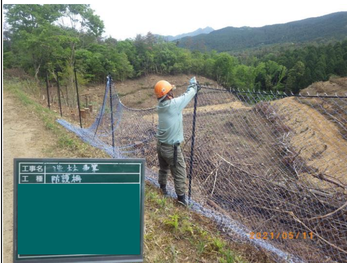
獣害防止施設設置作業
