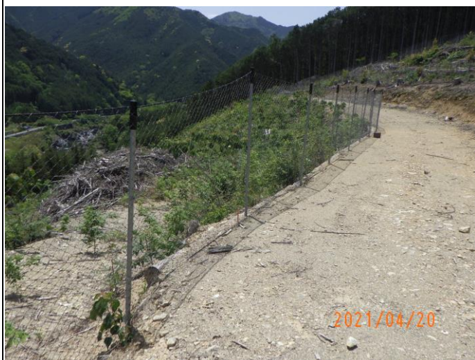
整備後点検状況
