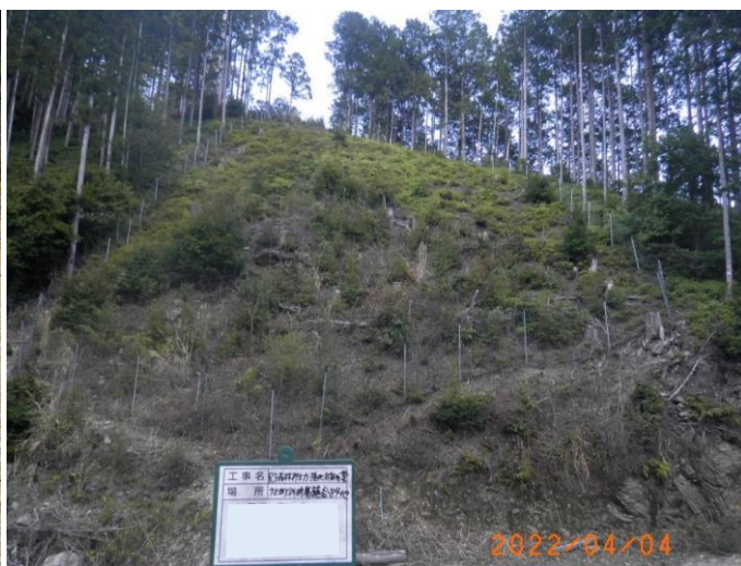
整備後点検状況
