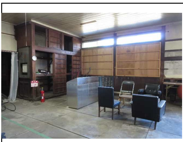
写真3 JR加太駅舎 旧事務室
