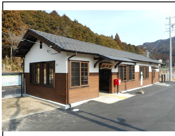
写真2 JR加太駅舎 外観完成
