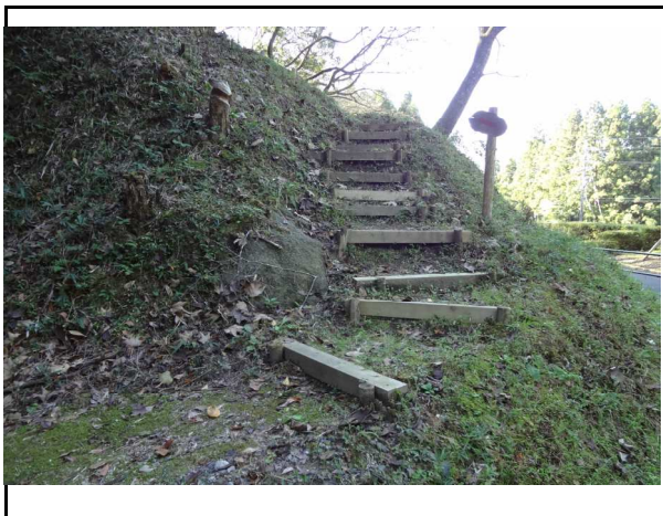
写真1 遊歩道階段補修
