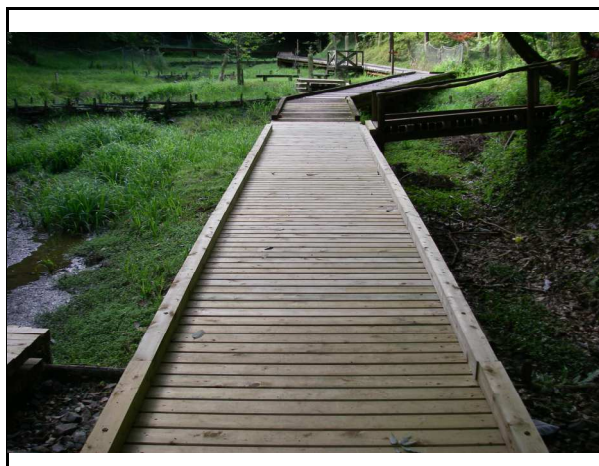
写真4 交換後（約8m）7月21日
