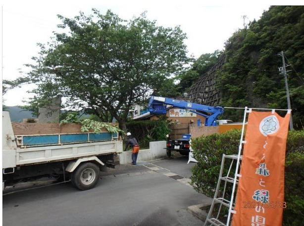
写真27 大紀町錦船附地区 作業中
