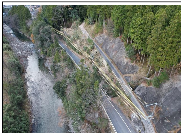
写真2 事前伐採(完成)松阪市飯高町乙栗子地内
