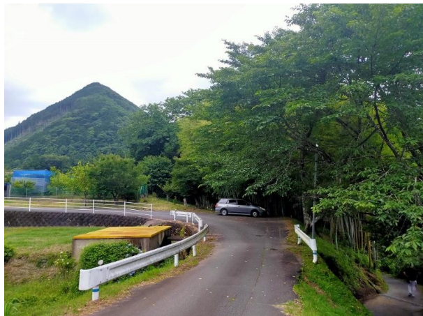
写真14 大紀町三瀬川久保海堂地区 生活道路に隣接する危険木
