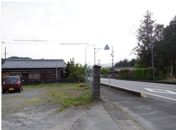
写真13 大紀町滝原下沖地区 作業中
