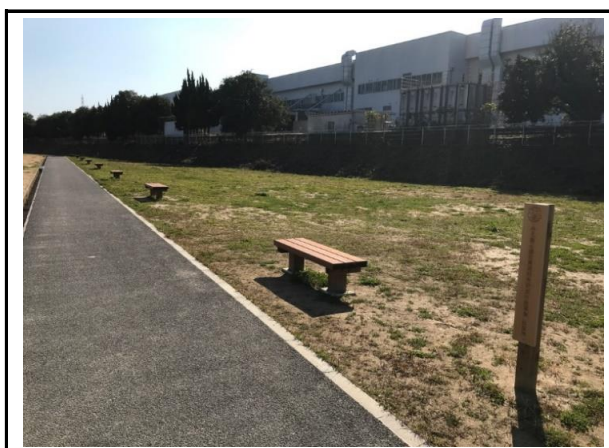
写真3 PR用標柱設置状況
