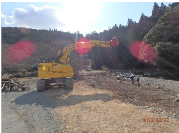
写真7 大紀町永会藤安場内 作業中
