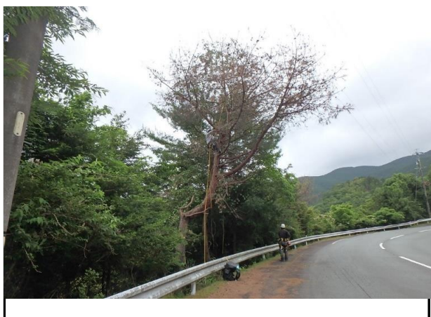
写真9 大紀町永会八ヶ河内地区 作業中
