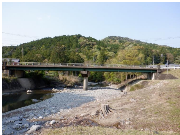
写真8 大紀町永会藤安場内 危険木除去後
