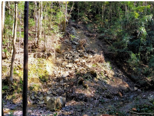
写真2 大紀町金輪東芦対地区 危険木除去後
