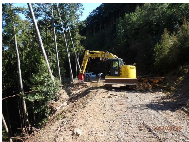
写真12 大紀町崎船久保地区 作業中
