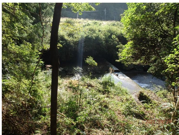
写真10 大紀町滝原坂東地内 危険木除去後
