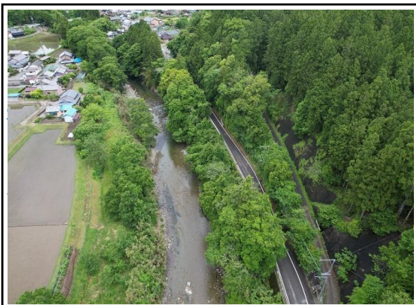
写真1 事前伐採(着手前)松阪市飯高町乙栗子地内
