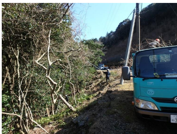
写真6 大紀町木屋竹利地区 作業中
