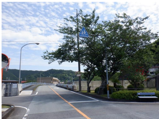
写真26 大紀町錦船附地区 生活道路に隣接する危険木
