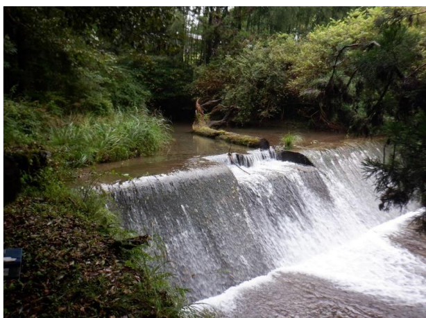
写真9 大紀町滝原坂東地内 溪流部の流出の恐れのある危険木
