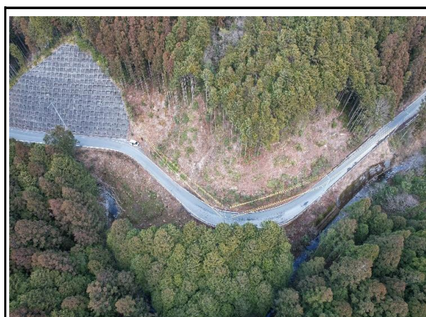
写真4 事前伐採(完成)松阪市飯高町宮本地内
