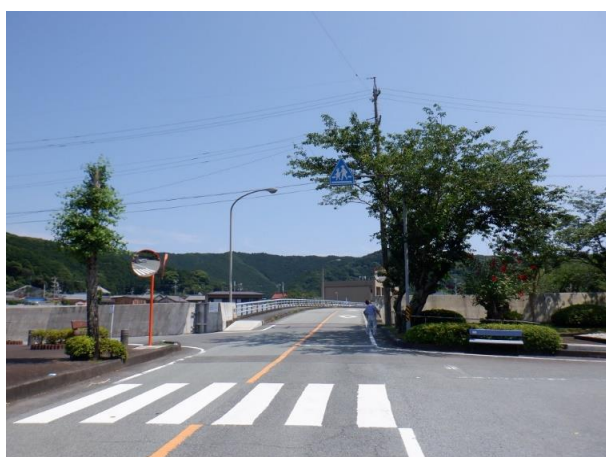
写真28 大紀町錦船附地区 完成
