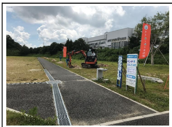
写真4 施工中 啓発用のぼり設置状況
