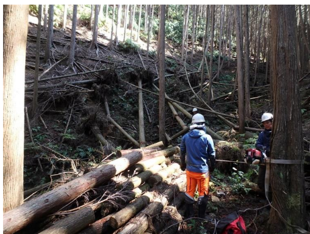
写真4 大紀町永会古里滝ノ上地区 作業中
