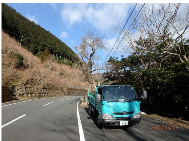
写真5 大紀町木屋竹利地区 生活道路に隣接する危険木
