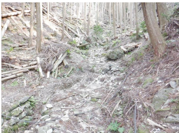
写真5 大紀町永会古里滝ノ上地区 危険木除去後
