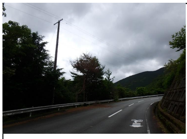
写真10 大紀町永会八ヶ河内地区 完成
