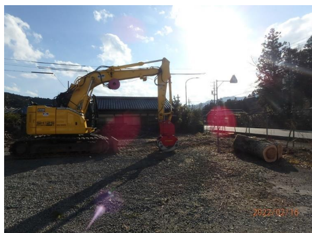
写真12 大紀町滝原下沖地区 作業中
