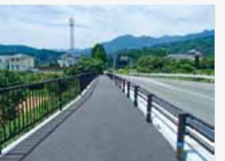
交通安全施設の整備(歩道整備) 一般国道 311号
