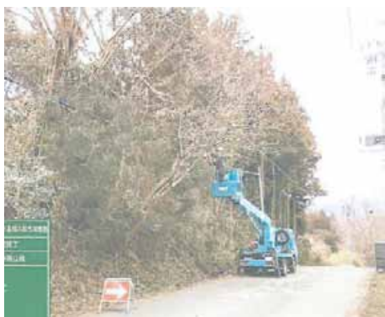
危険木の除去事業（主要道路） 交通の支障となる危険木を 伐採している様子
