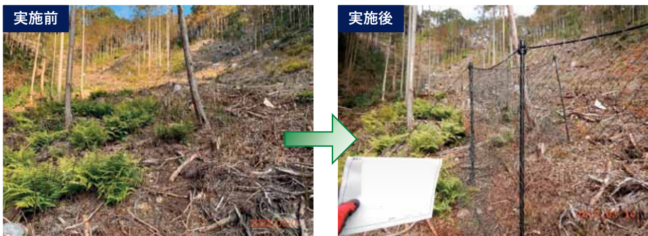
獣害防止施設の設置状況（紀北町）
