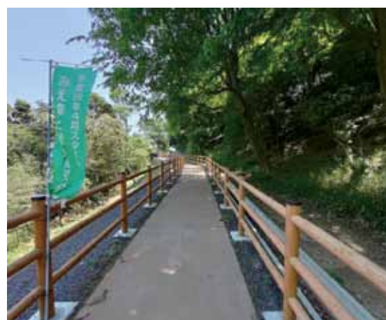
菰野富士ふるさとの山環境整備事業 バリアフリー木道の整備状況
