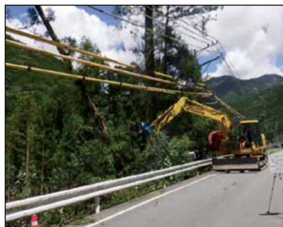
災害からライフラインを守る事前事業 電線沿いの危険木を伐採している様子
