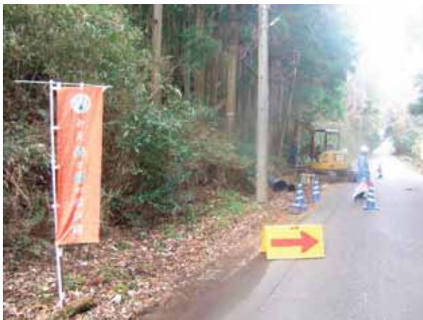
事前伐採の施工中の状況（多気町）
