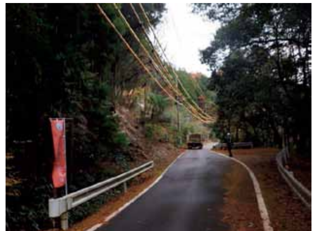
事前伐採の施工中の状況（松阪市）
