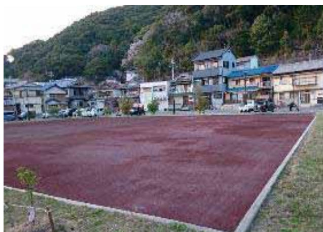
阿曾浦公園ウッドチップ舗装整備事業 ウッドチップ舗装された公園
