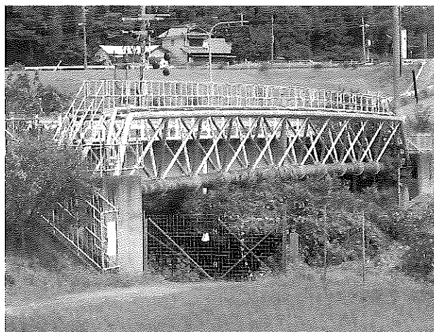
長野川水管橋 (津市)
