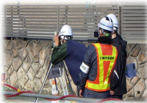
—測量機器を操作している生徒—
