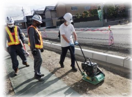
—転圧機械を体験中—
