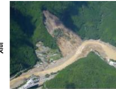
深層崩壊発生直後 (五條市清水地区)
