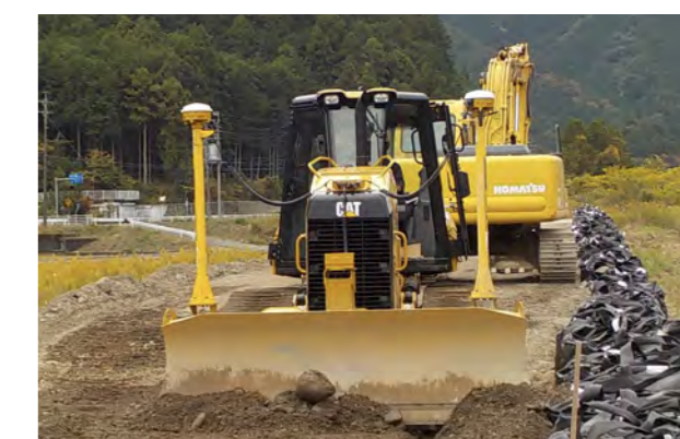
ICT建機施工状況
