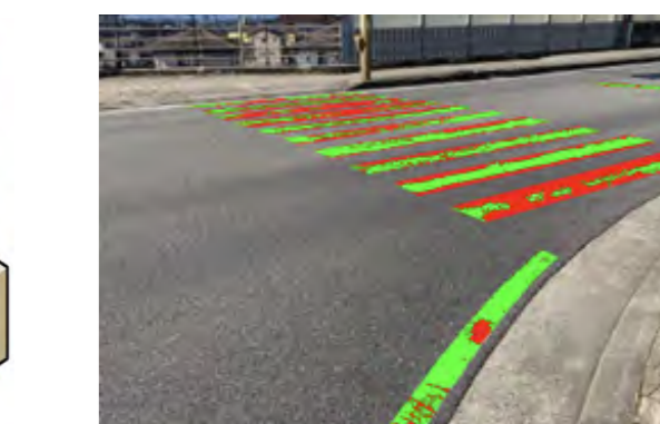
AI路面標示劣化検知システム
