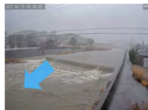
簡易型河川監視カメラ
