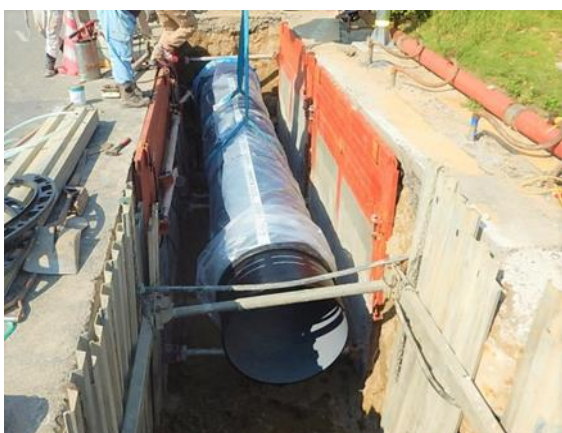
配水管布設替工事の施工状況
