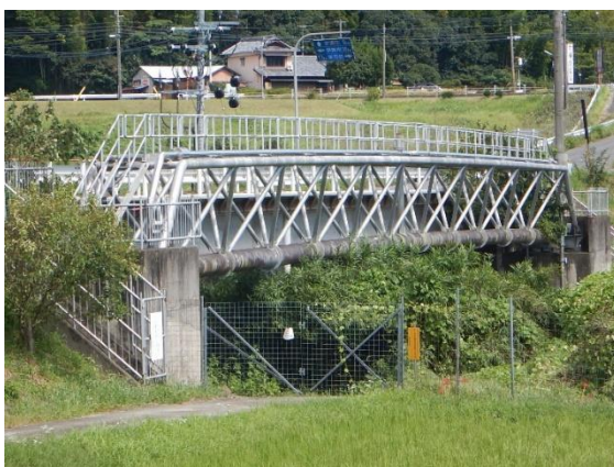
長野川水管橋 (津市)
