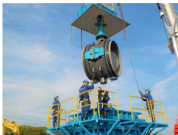
制水弁取替工事の施工状況
