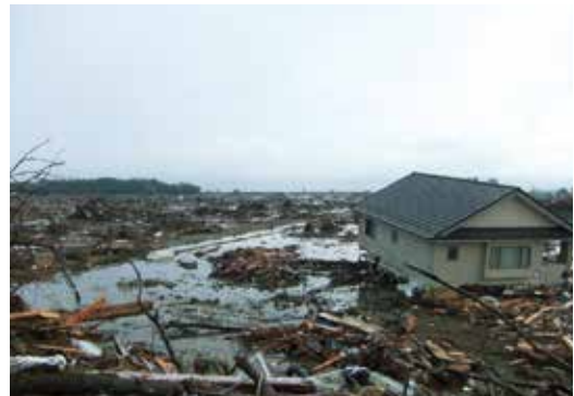
東日本大震災の被害
