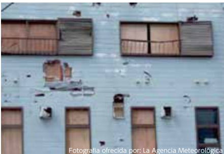
Paredes rotas debido a objetos
