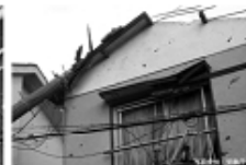
倒れた電柱で壊れた家
