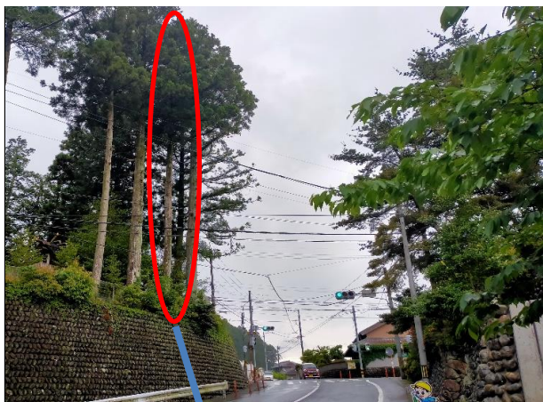
写真1 大紀町野原地区 生活道路に隣接する倒木の恐れのある危険木
