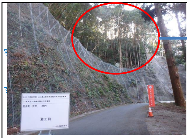
写真1 ②町道川南線(伐採前)
