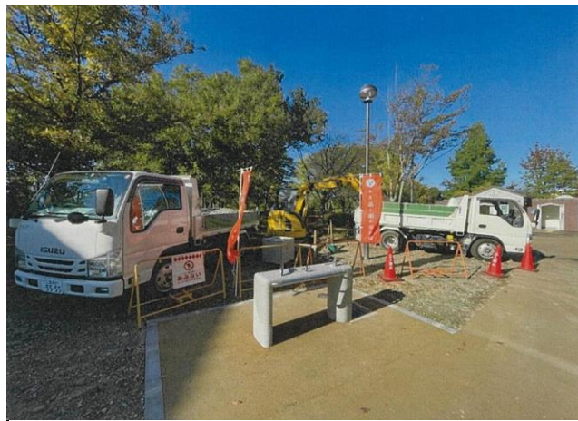
写真2 東屋整備 工事中 ぼりによるPR状況
