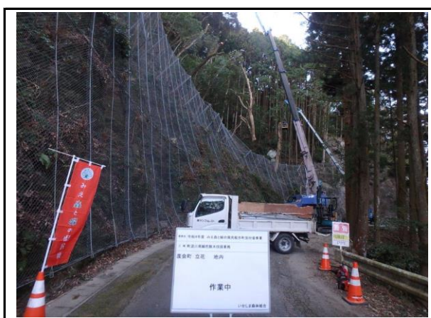
写真5 ②町道川南線(作業中) 県民税のぼり
