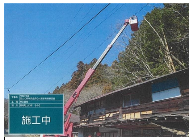
写真4 支障木伐採(作業状況)松阪市飯南町上仁柿地内 高所作業車使用
