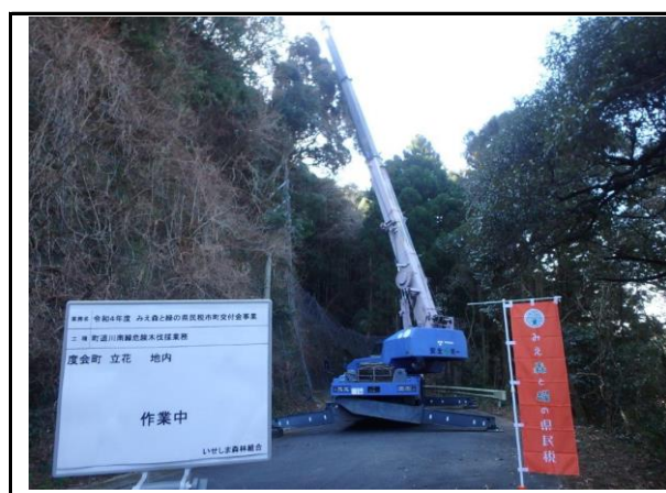
写真6 ②町道川南線(伐採後)
