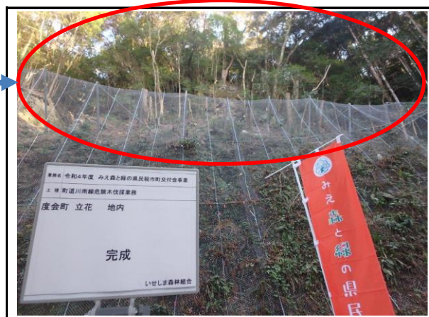
写真4 ②町道川南線(伐採後)
