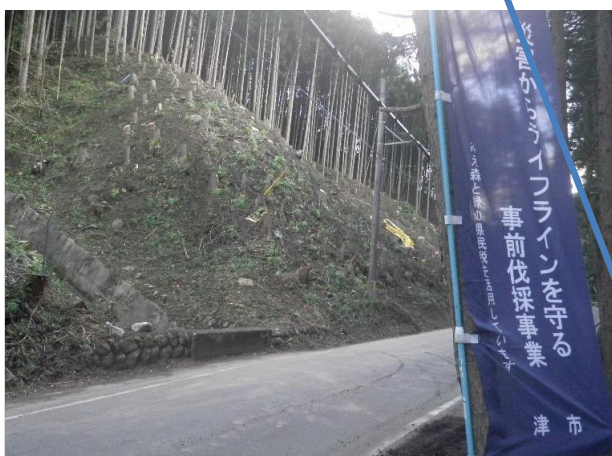
写真3 災害からライフラインを守る事前伐採事業 (美杉町八知地内 実施中)
