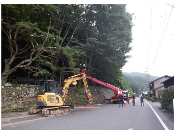
写真11 大紀町阿曾・片倉地区 作業中 (高所作業車・グラップル使用)
