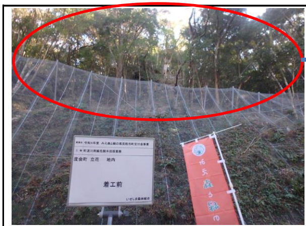
写真3 ②町道川南線(伐採前)
