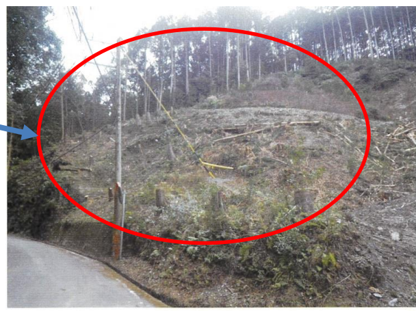
写真4 多気町古江地内 (伐採後)
