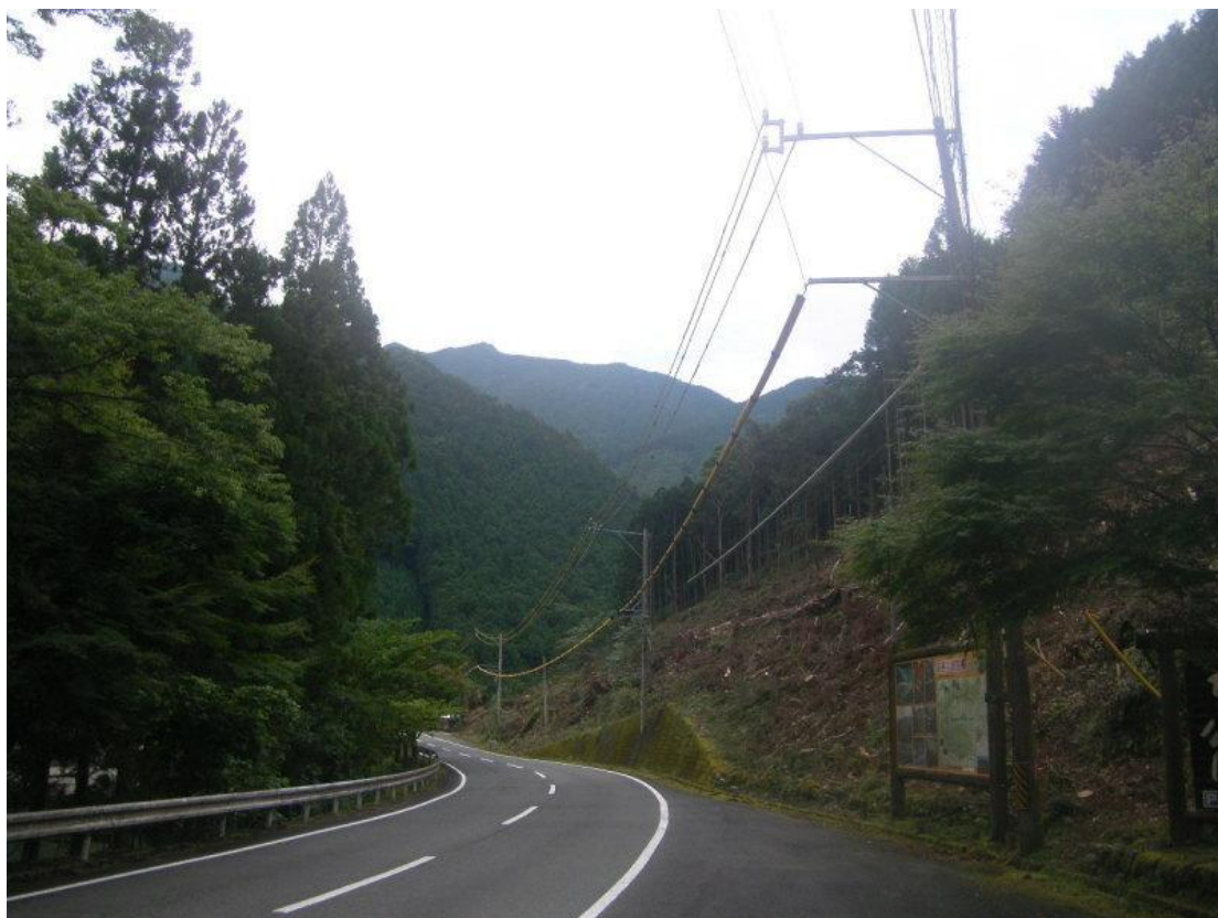
(施業前) 大台町滝谷地内
