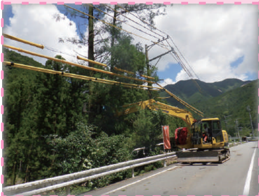
災害からライフラインを守る事前伐採事業 (岩井地内)
