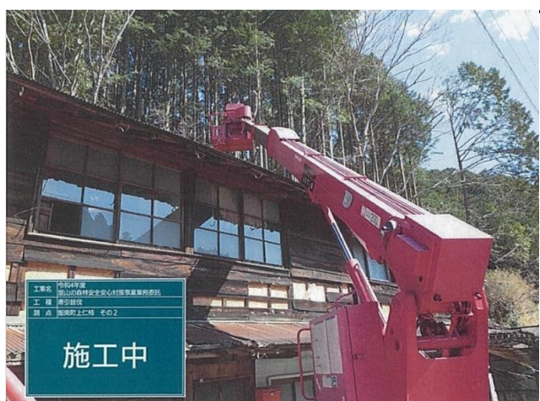
写真3 支障木伐採(作業状況)松阪市飯南町上仁柿地内 ラフタークレーン使用
