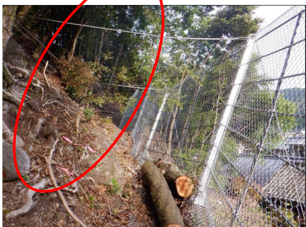
写真15 大紀町崎・宮原地内 完了
