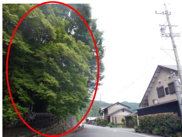
写真10 大紀町阿曾・片倉地区 生活道路に隣接する倒木 や枝の落下の恐れのある危険木
