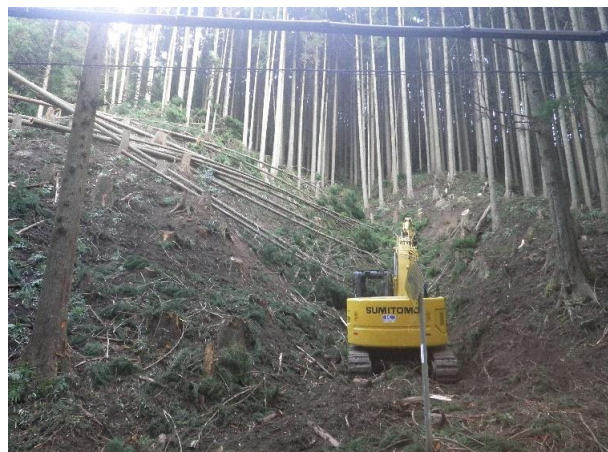
写真2 災害からライフラインを守る事前伐採事業 (美杉町八知地内 実施中)
