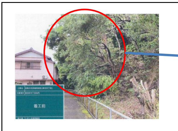
写真1 鳥羽五丁目 施工前
