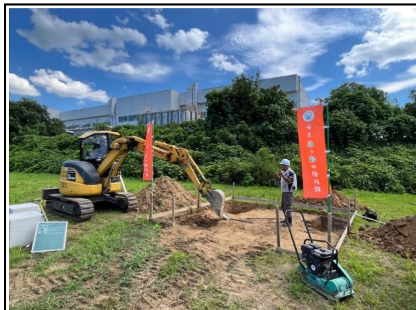
写真2 施工中 啓発用のぼり設置状況
