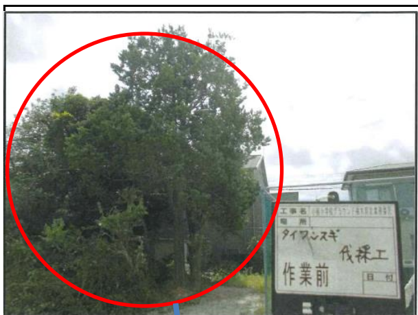
写真1 作業前(小俣小学校)
