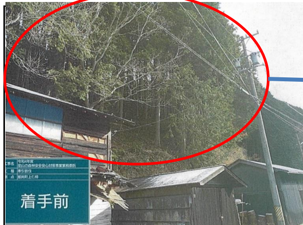
写真1 支障木伐採(着手前)松阪市飯南町上仁柿地内 国道筋の人家浦で倒木の恐れがあり、危険であった
