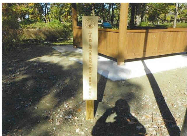
写真3 東屋整備 完成 木製プレートの設置状況
