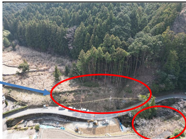
写真2 事前伐採(完成)松阪市飯南町下仁柿地内
