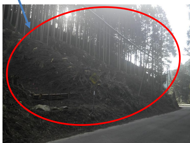
写真6 災害からライフラインを守る事前伐採事業 (美杉町八知地内 実施後)
