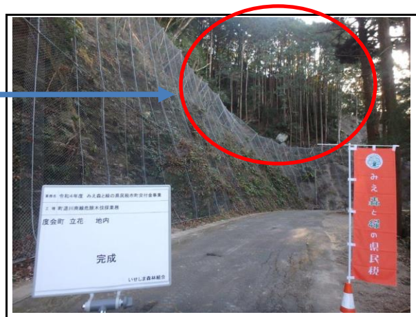
写真2 ②町道川南線(伐採後)
