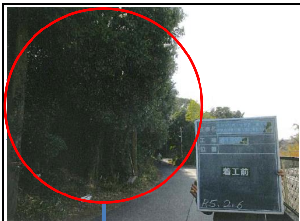
写真1 作業前(倉田山中学校)
