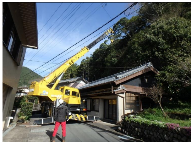
写真14 大紀町崎・宮原地内 作業中(クレーン車使用)
