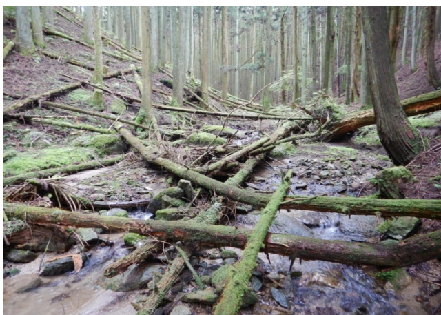
事例5 伊賀市(折戸) 整備前
