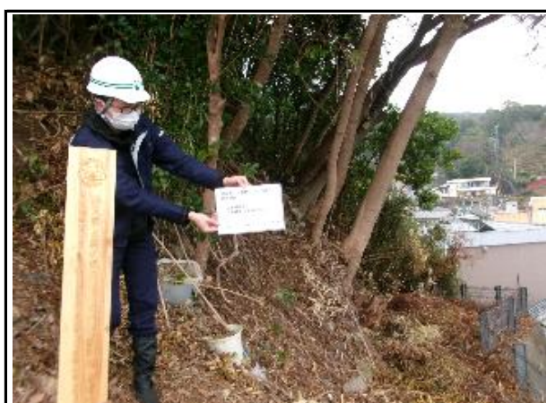
写真5 看板設置 (三木浦地区)
