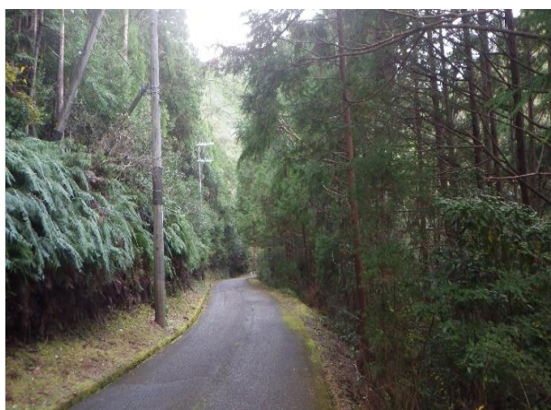
写真3 危険木伐採前 町道西原阪本線
