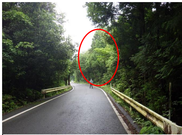
写真2 危険木伐採後 町道引作山地線
