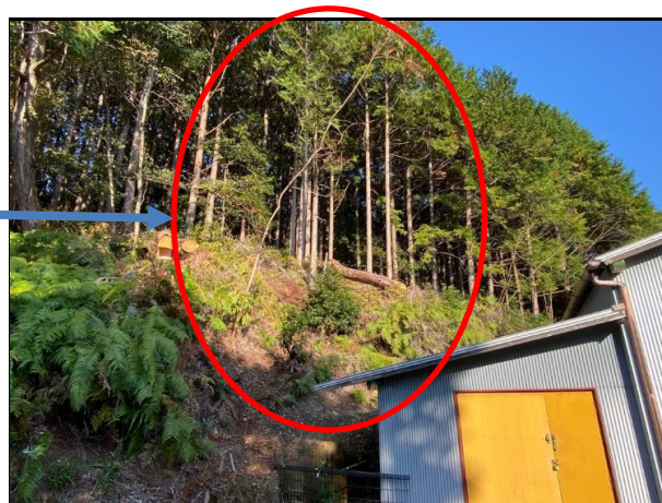
写真2 三浦区【実施後】
