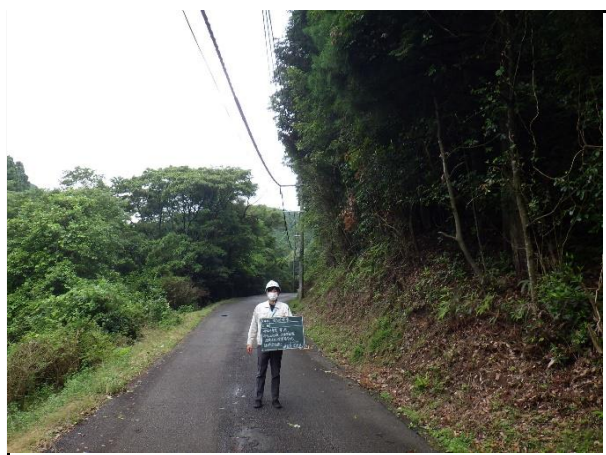
写真4 危険木伐採後 町道西原阪本線
