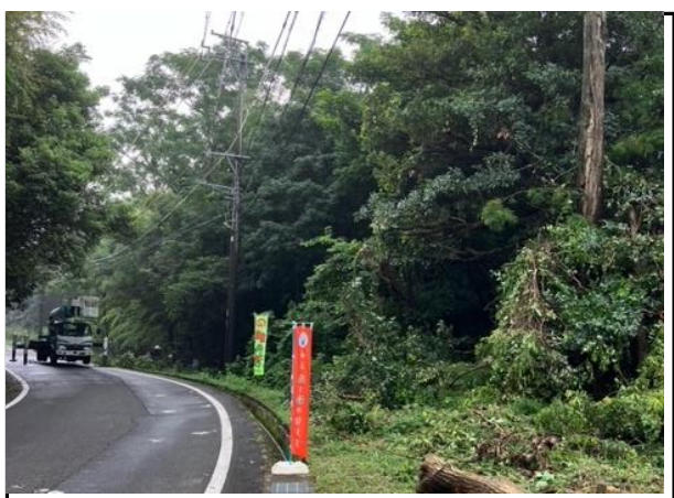
写真5 工事中(のぼり掲示)
