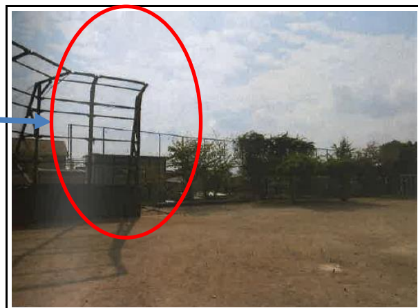
写真8 大谷台小学校・着工後 (伐採)
