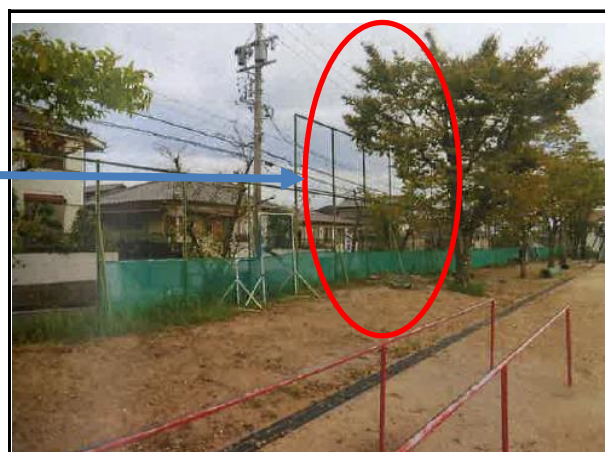
写真10 大谷台小学校・着工後 (伐採)
