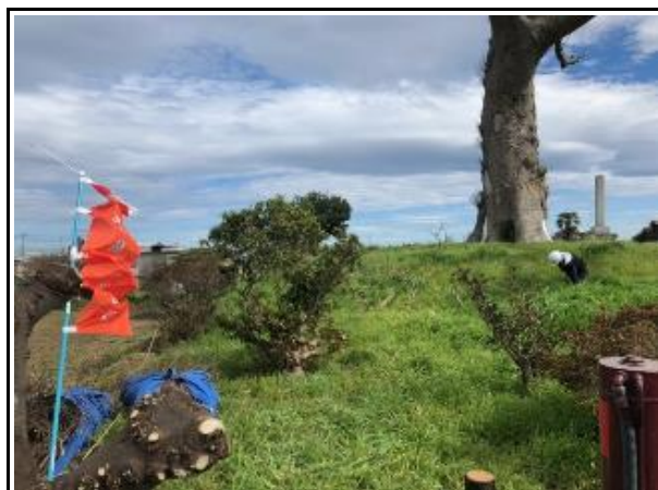
写真2 枯れ枝の切除
