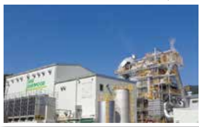
▲木質バイオマスの発電施設
