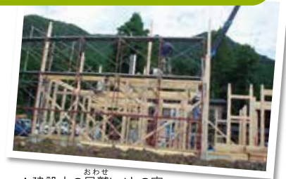
▲建設中の尾鷲ヒノキの家
