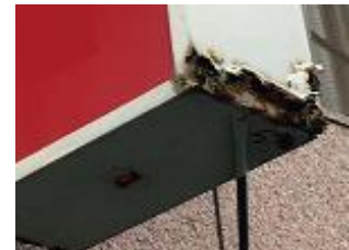
広告板底部の腐食が進行した状態
