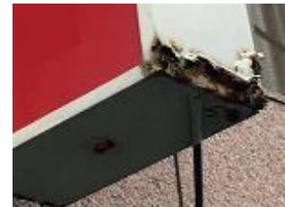
広告板底部の腐食が進行した状態
