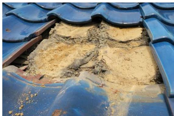
図 1 解体家屋の壁土(上)と屋根瓦下の土(下)
