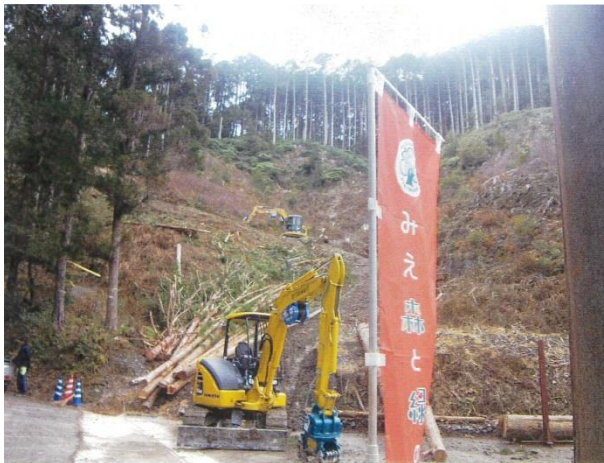
伐採作業の状況
