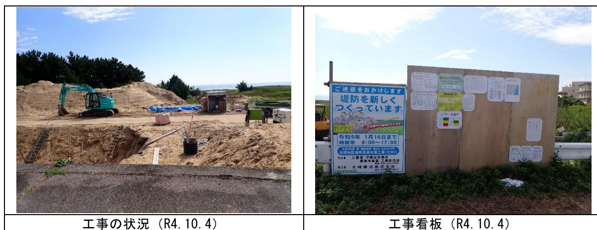
写真 2.2.3 幼虫 L-1 付近で行われていた堤防工事
