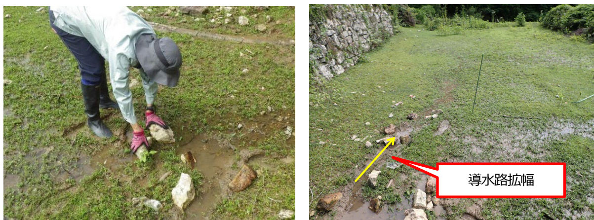
図 2.3.4 維持管理作業状況
