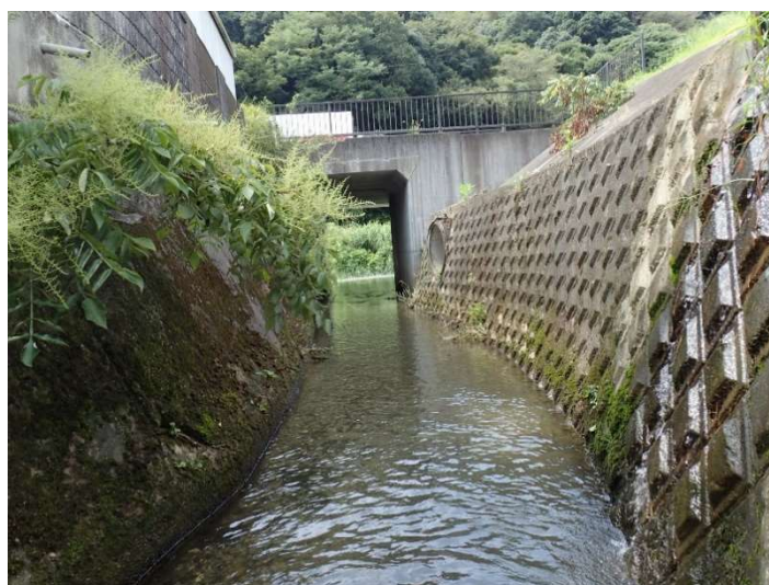
写真 4-3 調査地点 W3 の状況（令和 4 年 8 月 24 日）
