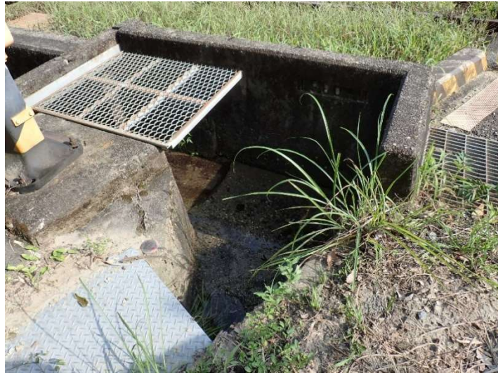
写真 4-4 調査地点 W4 の状況（令和 4 年 8 月 24 日）
