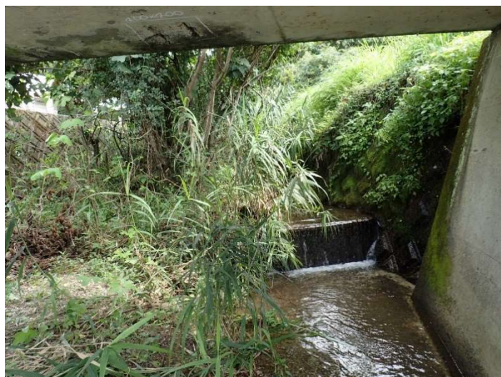
写真 4-2 調査地点 W2 の状況（令和 4 年 8 月 24 日）
