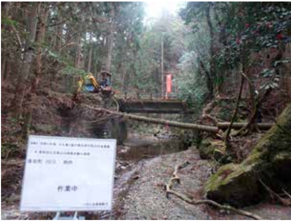
流倒木撤去事業 作業実施状況
