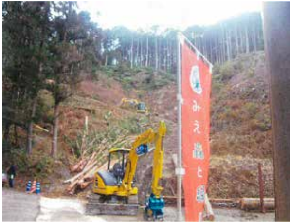
事前伐採の施工中の状況（多気町）
