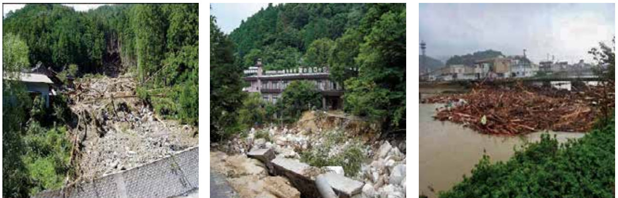
台風や豪雨による被害の状況
