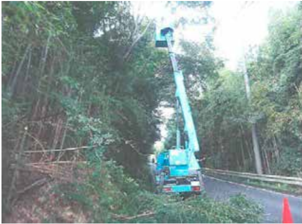
危険木の除去事業（主要道路） 交通の支障となる危険木の 伐採状況
