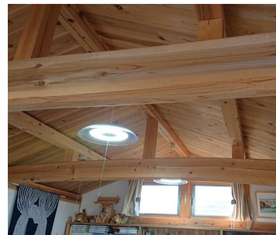
構造材や内装材等に県産スギ、ヒノキをふんだんに使用
